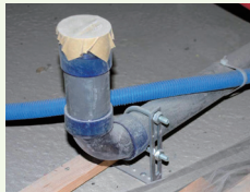
排水パイプの起点部・立上り部の支持に
