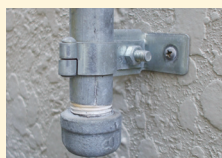
プロパンガス接続配管
