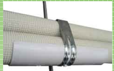
SCキープハンガーを使用した施工例
