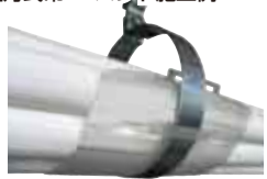
提灯式吊VPバンド施工例
