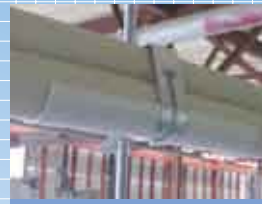
SCキープハンガーを使用した施工例
