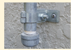
プロパンガス接続配管
